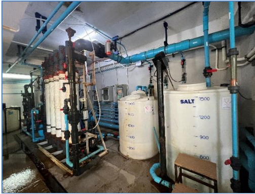
ระบบปรับปรุงคุณภาพน้ำและถังเก็บน้ำดีที่ผ่านการกรองแล้ว
